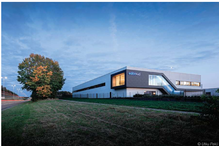
Le tout nouveau siège de la filiale wallonne du groupe Edibo (construction) à Fernelmont.
